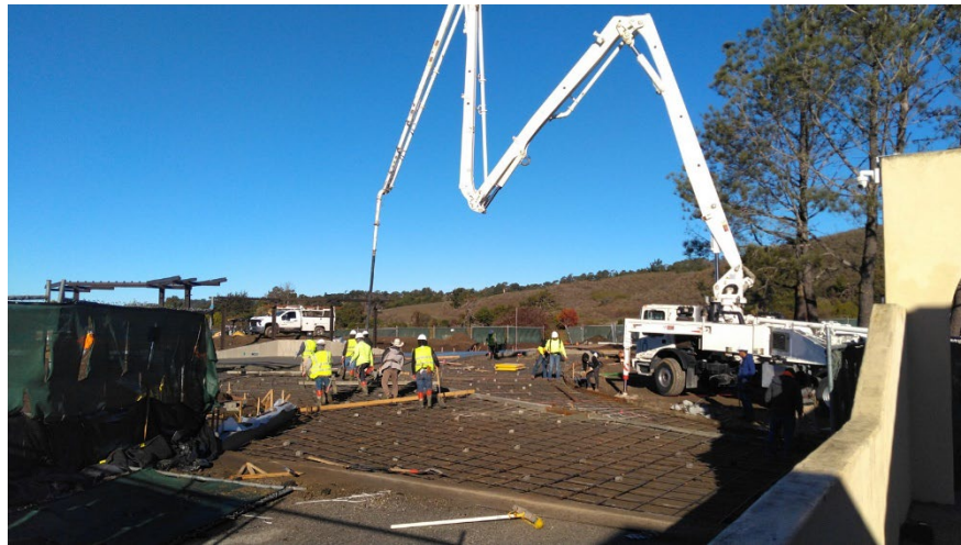
Project-B Concrete Pour
